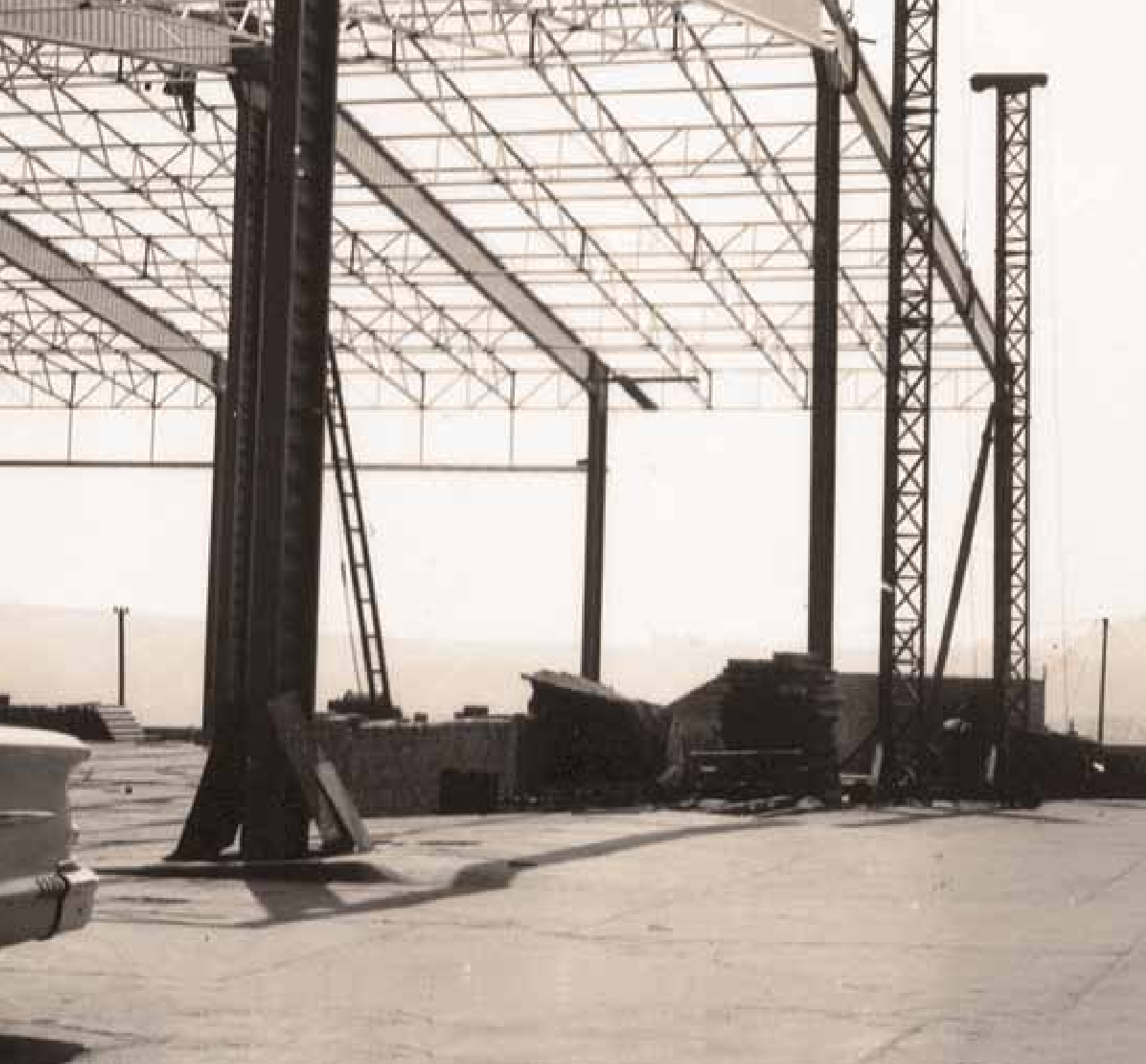
Acima, nova fábrica de São Bernardo do Campo em construção
